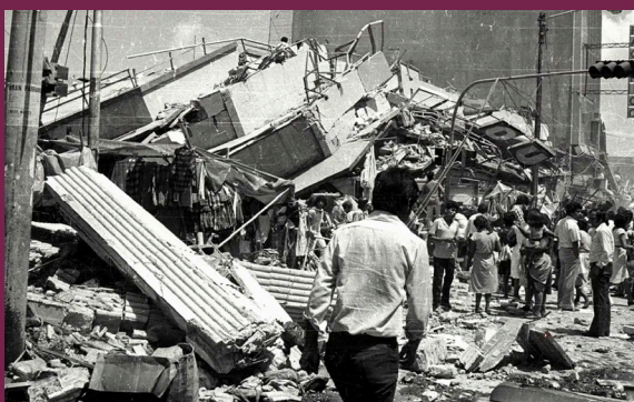
Terremoto en el Salvador, 1986.
